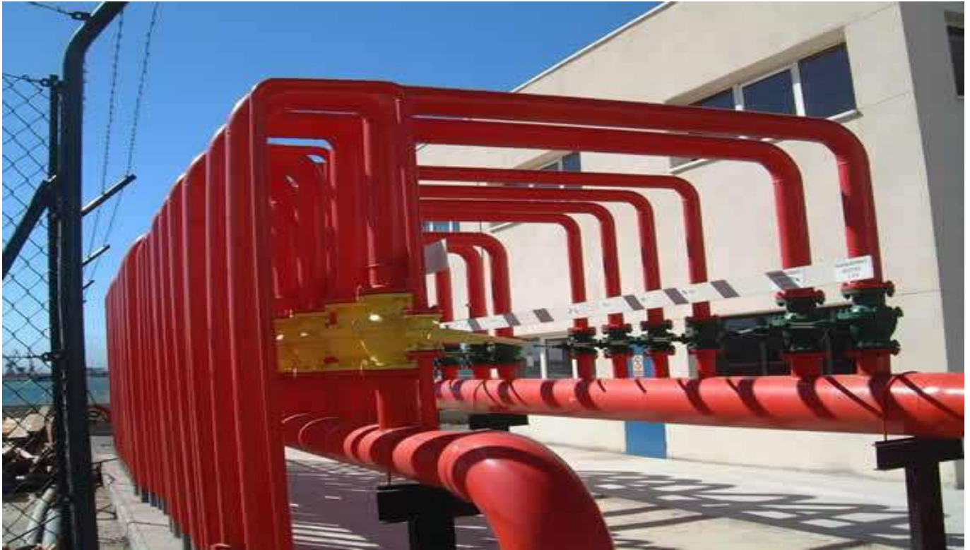
MONTAJE CONTRA INCENDIO (VILLA VERDE DEL CAMPO) MADRID
